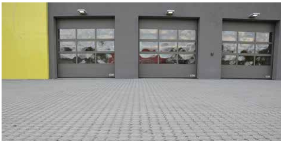
ASKER AMBULANSESENTRAL. Trafikk-/ parkeringsareal for tynge kjøretøy. Produkt: Permac Lock Dren. Utført av Lintho Steinmiljø 2016.
