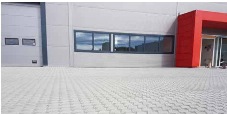
NORGESDEKK, ENEBAKK. Parkeringsplass, industriområde. Produkt: Permac Lock Dren. Utført av Lintho Steinmiljø AS i 2016.
